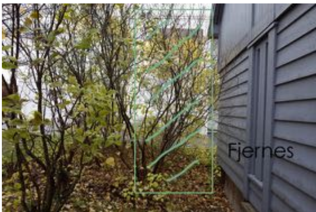
Syrinene ved stabburet vokser for tett på bygningen. Dette vil bidra til et fuktigere klima opp mot bygningen og råte i panel på sikt.
